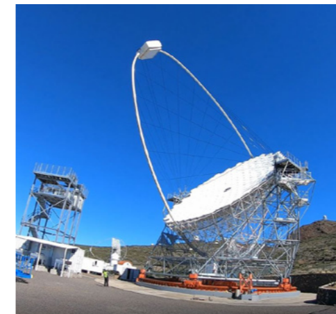
Arche composite haubanée et automatisation du positionnement du Large Size Telescope de CTA (îles Canaries)
